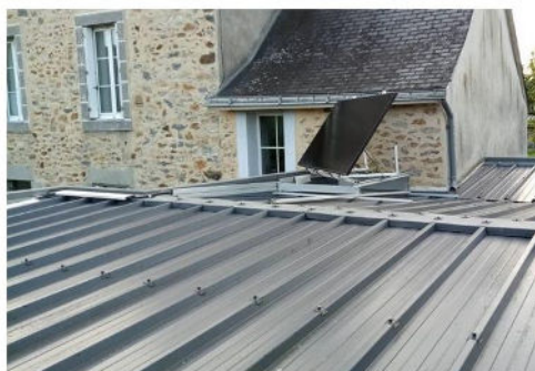
INSTALLATION inclinable et orienté sans suivre la pente et l'orientation du toit Jérôme Louvenné
