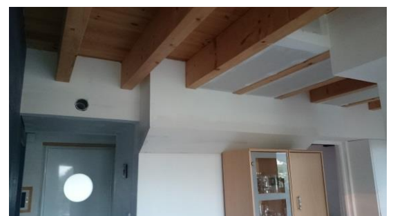
De gauche à droite : perçage des cloisons pour passer les gaines, pose de la machine et raccordement des gaines. En bas : création d'un coffrage pour camoufler les gaines.
